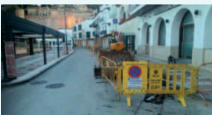
Obres de millora realitzades per SOREA
